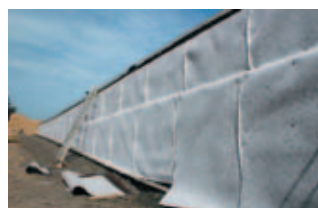
Защитная мембрана с функцией дренажа
