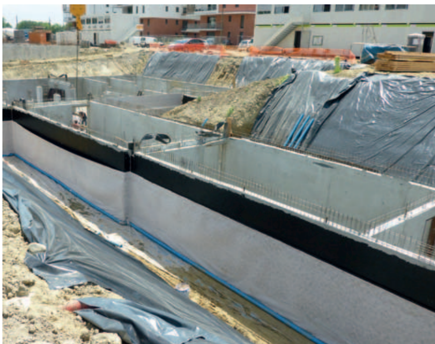
Защита и дренаж стены подвала многоквартирного дома.
