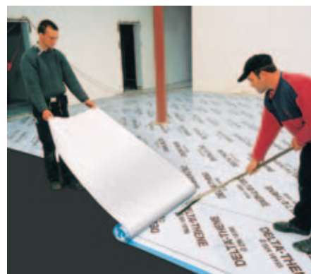
Большие поверхности могут быть легко и быстро защищены с помощью гидроизоляции DELTA®-THENE.
