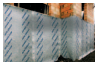
Дренажная мембрана повышенной прочности с эффектом энергосбережения
