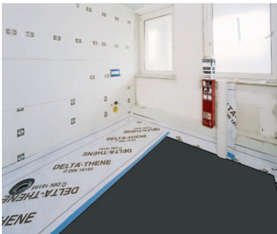
Надежная гидроизоляция во влажных помещениях.
