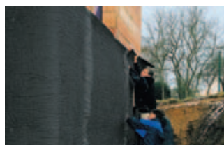
Дренажная мембрана с выступами высотой 9 мм
