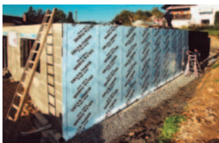
Надежная защита стен подвала
