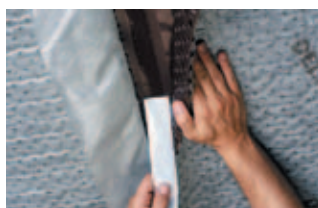
Дренажная мембрана со скользящим слоем для пучинистых грунтов
